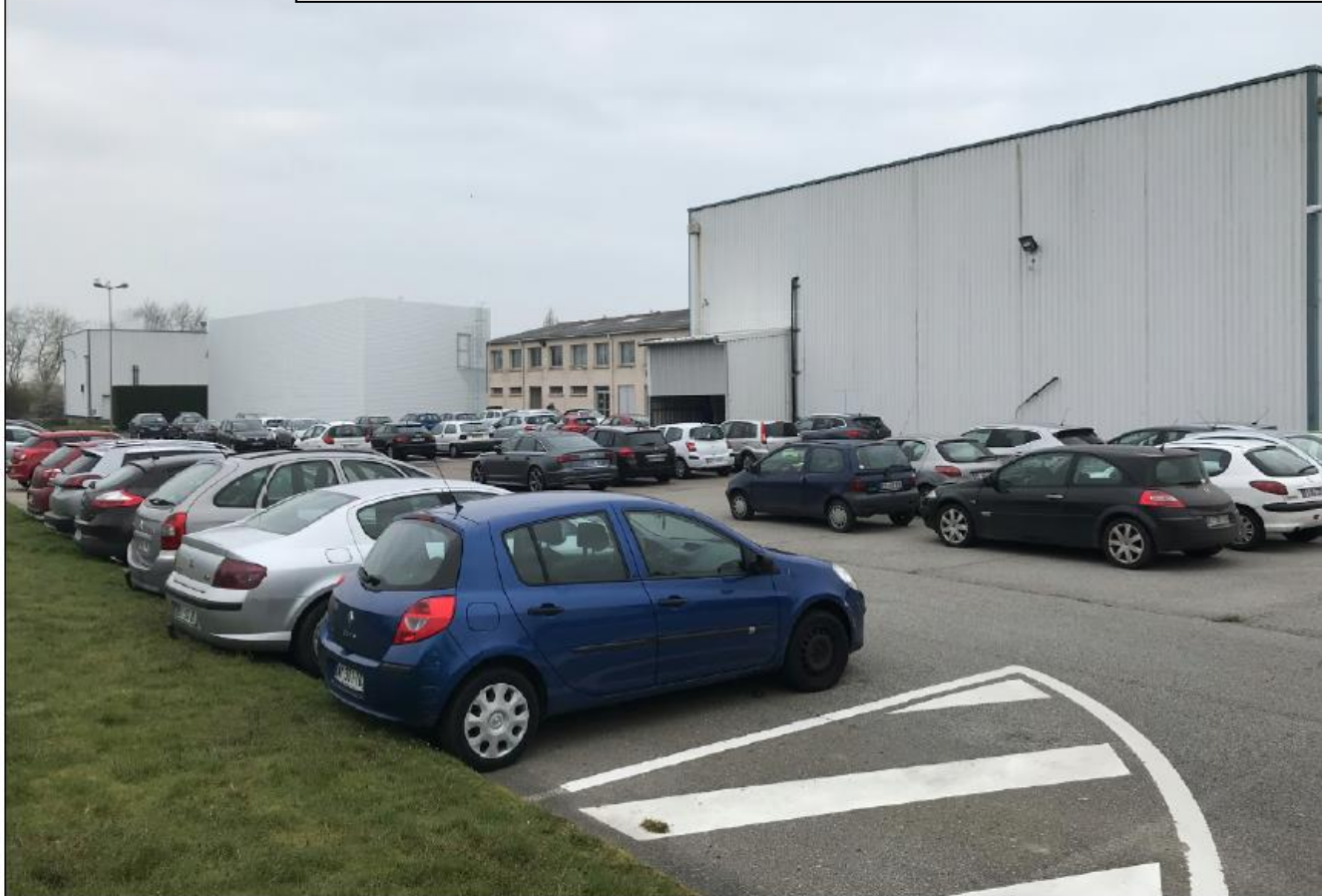
APRES PROJET (Façade SUD, extension chambres froides des en-cours et zone de transfert)
